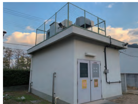
▲排水設備の様子
